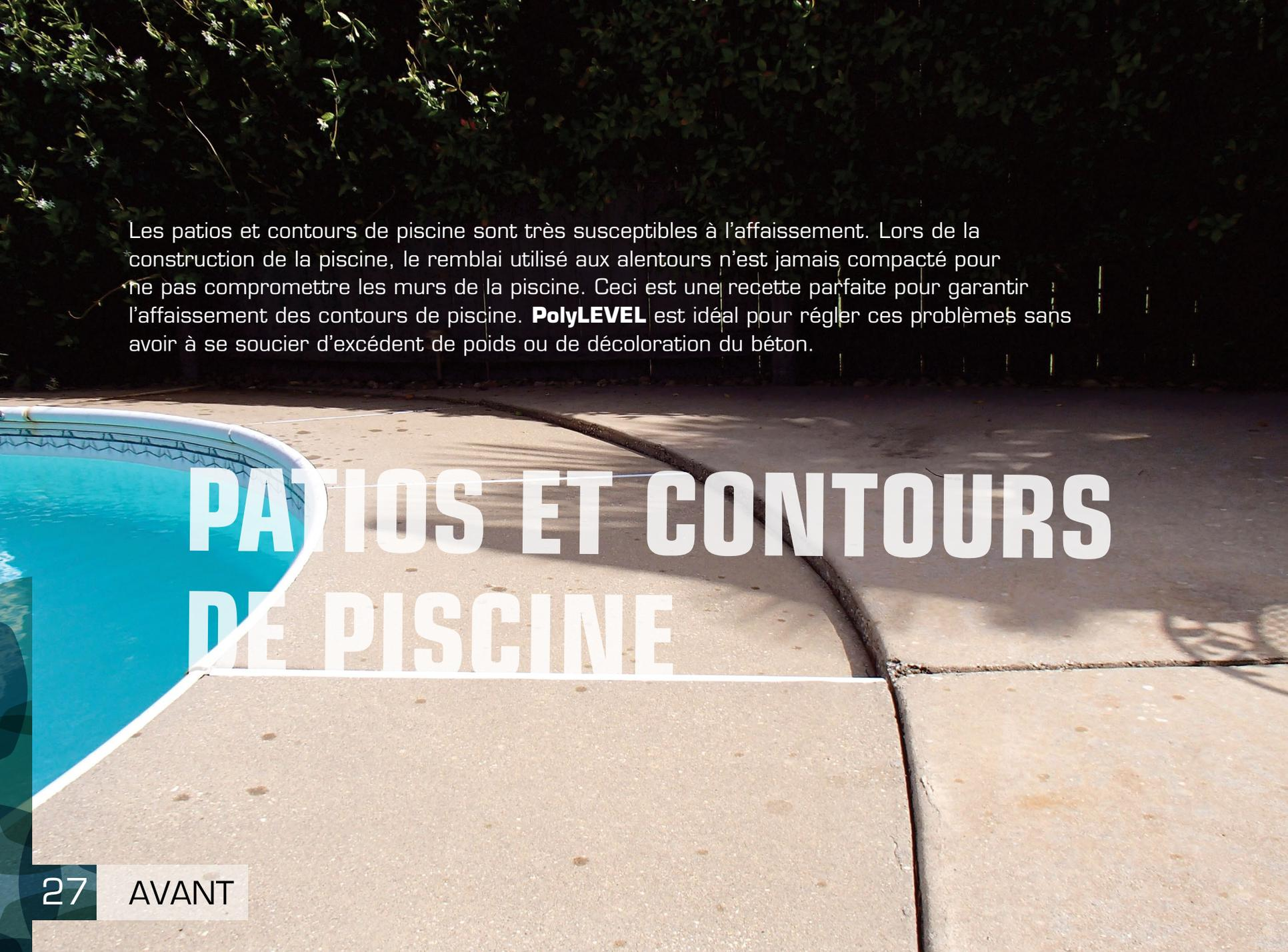
Les patios et contours de piscine sont très susceptibles à l'affaissement. Lors de la construction de la piscine, le remblai utilisé aux alentours n'est jamais compacté pour ne pas compromettre les murs de la piscine. Ceci est une recette parfaite pour garantir l'affaissement des contours de piscine. **PolyLEVEL** est idéal pour régler ces problèmes sans avoir à se soucier d'excédent de poids ou de décoloration du béton.
